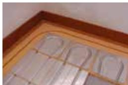
im nächsten schritt, folgen die umlenkplatten mit dem entsprechendem verlegeabstand va 125 oder va 250 mm auf der gesamten auszulegenden breite des heizkreises bzw. raumes.
