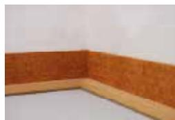
im nächsten schritt folgen die randhölzer, die mit der weicheren seite nach unten entlang aller durch randdämmstreifen geschützten bauteile verlegt werden. die randhölzer, erlauben die nutzung der angegebenen flächen und punktlasten der hersteller des trockenestrichs und oder des oberbelagerherstellers auch bis in die letzte ecke eines raumes. die maximalbelastung des gesamten aufbaus, richtet sich nach der maximalbelastungsangabe des schwächsten bauteils der gesamtkonstruktion.
