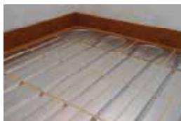
im weiteren verlauf, werden die flächenelemente entsprechend der vorplanung und des benötigten verlegeabstand va 125 oder va 250 mm ausgelegt. achten sie bei der verlegung darauf, dass alle systemelemente möglichst ohne lücken dicht an dicht liegen und die rohrführungen der einzelnen systemelemente sich in einer flucht fortsetzen.
