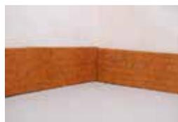
entspricht der untergrund den ebenheits und winkeltoleranzen der DIN 18202, werden zuerst die randdämmstreifen zur bauteiltrennung entlang wände, säulen, türen oder treppen auf der ebenen und besenreinen rohdecke verlegt. die randdämmstreifen, dürfen erst nach fertigstellung des oberbodens abgeschnitten werden und die fuge muss dauerelastisch verschlossen werden.
