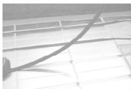
das heizrohr vom verteilner aus beginnend in die speziellen – führung der wärmeleitlamellen einbringen. die nutzung einer abwickelvorrichtung, erleichtert die verlegung des heizrohres. als heizrohre, sind nur bavaria-press rohre mit der dimension 16 x 2,0 mm zu verwenden.
