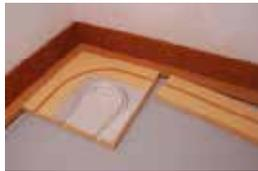
sind in der vorplanung eine oder mehrere zuleitungen geplant, so beginnen sie mit der entsprechenden anzahl der zuleitungselemente und einem heizkreis- anfangs- bogen.
