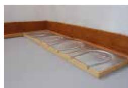
entsprechend der vorplanung, beginnen sie in der linken ecke der längsten raumseite, bevorzugt an außenwänden mit der verlegung der umlenkbereiche.
