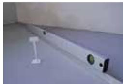
überprüfen sie den sauberen, lastabtragenden boden auf ebenheit nach DIN 18202. notwendige ausgleichsarbeiten führen sie entsprechend vor verlegung der systemplatten durch.
